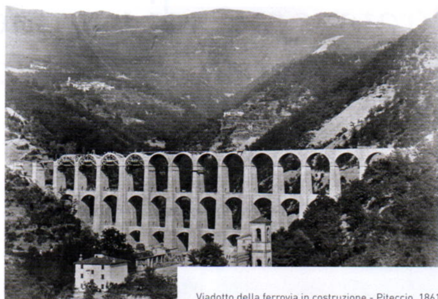
Viadotto della ferrovia in costruzione - Piteccio, 1861
